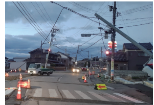
石川県輪島市内にて（撮影日1月11日）
